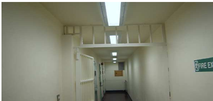
STR236/RM/HF/O/- wersja do zabudowy, 2x36W/T8/ opal , w zakładzie karnym
